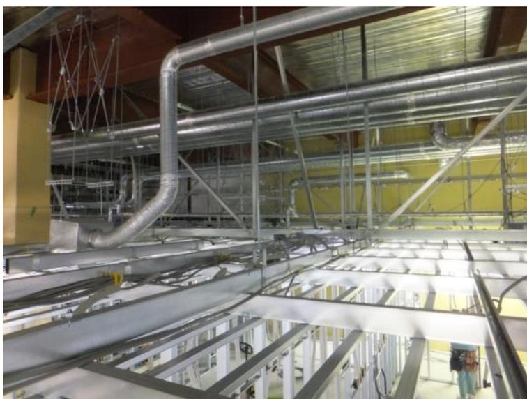
写真 9 直貼り天井部（45mm 角形鋼管野縁材）
