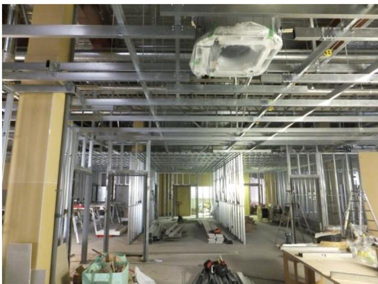
写真 12 天井下地材・全景
