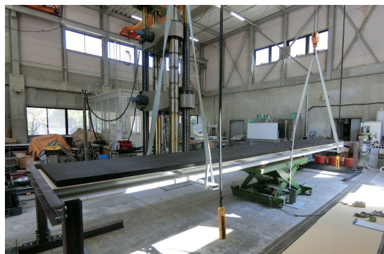
写真は近畿大学工学部構造実験棟(広島県東広島市)
