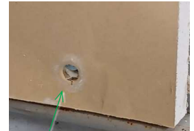
ボード原紙剥離 垂鉛めつき切板変形
