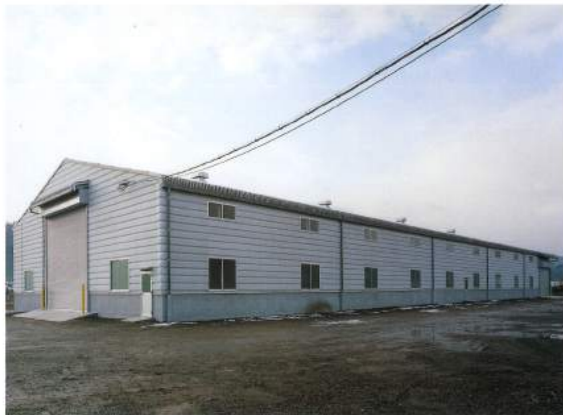
外壁下地材KH-100NF (0.6) + 屋根下地材KH-100ST (0.6) 使用
