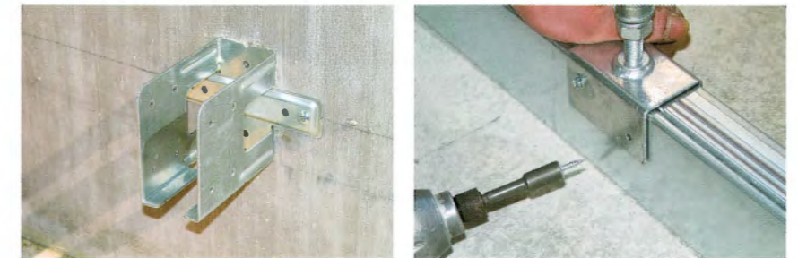
① タンゴのレベルを出して、コンクリート基礎にコンクリートアンカーで確実に固定する。 ② 角型大引鋼に専用鋼製束を専用ファスナーで取付ける。
