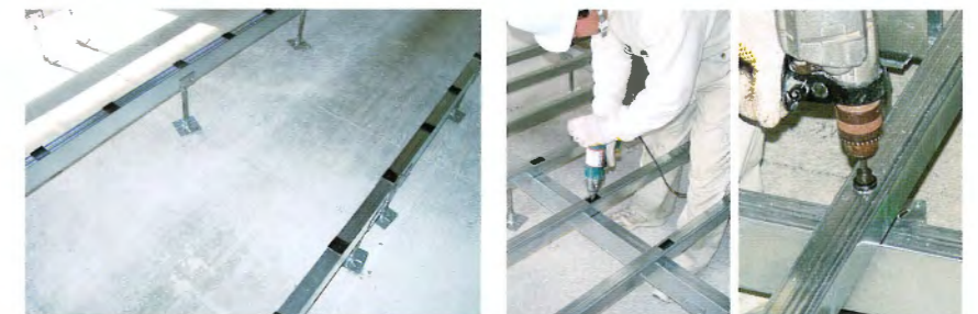
⑦ 角型大引鋼上の角型根太鋼を固定する位置にゴム板を貼る。 ⑧ 角型根太鋼の角穴(ビス留め穴)に、専用ファスナーをセットした磁石付きのビットを差込んで角型大引鋼に留める。角穴が無い場合は、ホールソーでビットが入る穴を開ける。
