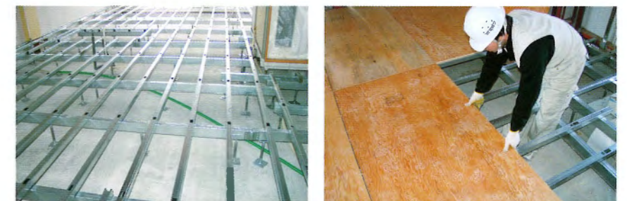
⑨ 下地組取付け完了。 ⑩ 捨貼合板を壁際2~3mm、根太上で1mm程度隙間を明けて、ドライウォールフレキビス(SKH(O.8)LGB(1.0)用)又はフレキジャックポイントビス(SLGB(1.2)用)で固定する。
