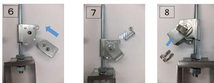
6. 穴の位置が重なるように④ロックブラケットをはめる。7. ⑤ピンを穴に通す。8. ⑤ピンの反対側の溝に合わせて⑥クリップを留める。
