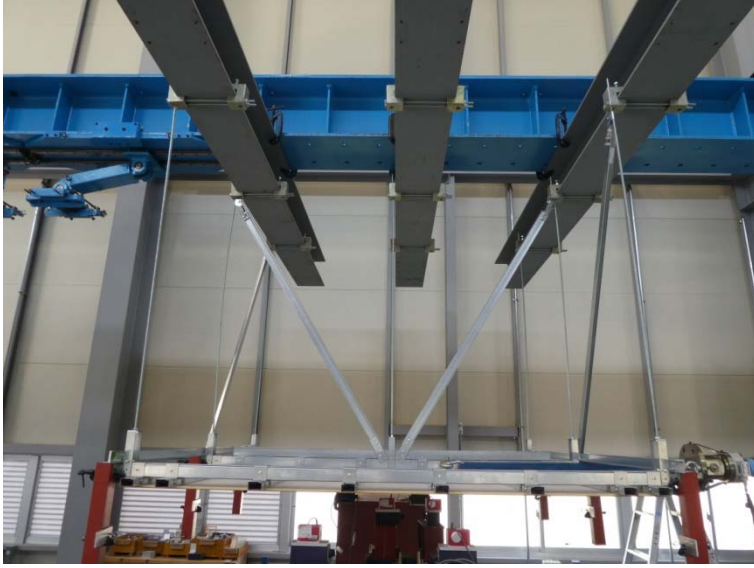
写真－6 試験体の状況（最大荷重時）
