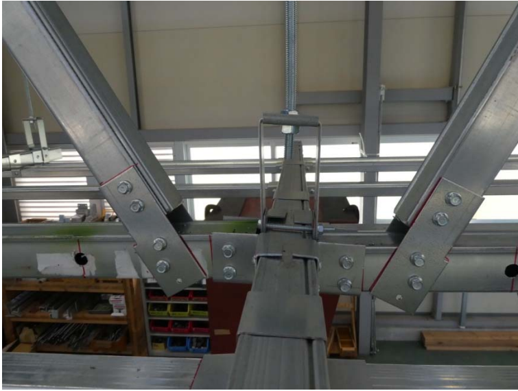
写真－9 試験体の状況（最大荷重時）
