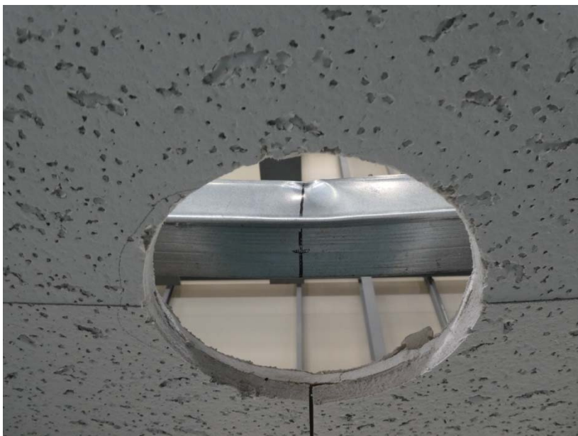
写真-4 試験体の状況（試験後）
