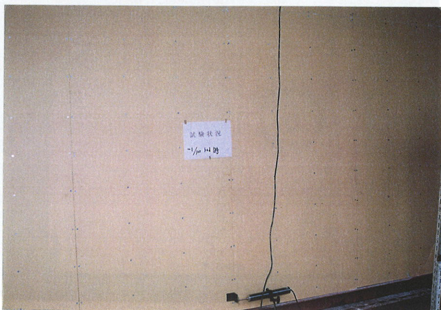
写真-6 試験状況 試験体：H-40 \gamma = -1/100 rad時 せっこうボードの割れ
