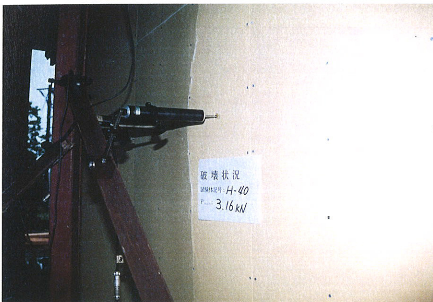
写真-3 破壊状況 (試験体記号: H-40)
