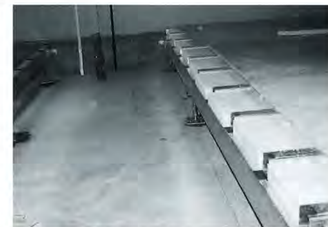
ポリスチレンフォーム使用施工例
