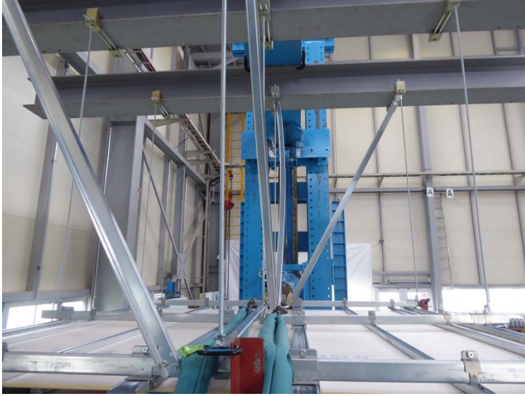
写真－9 試験体の状況（最大荷重時）
