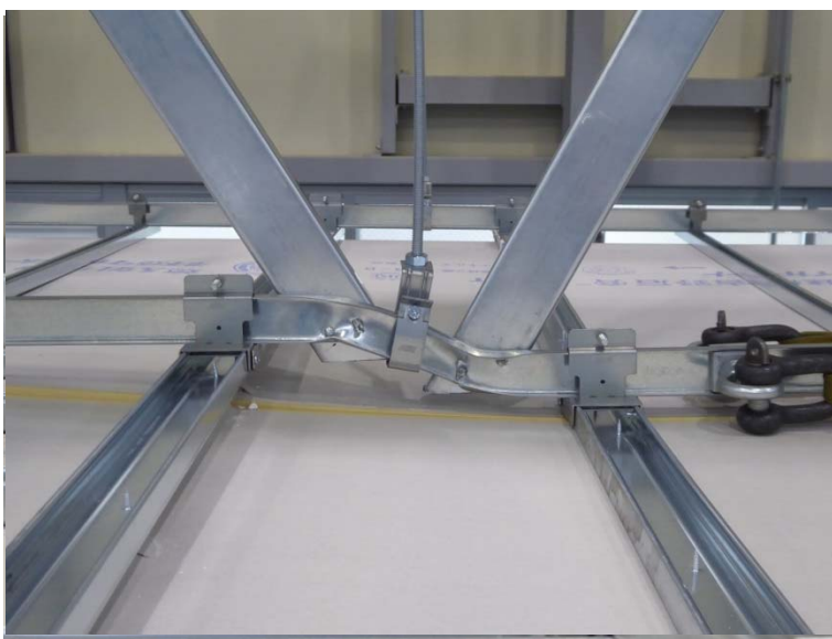
写真－8 試験体の状況（最大荷重時）
