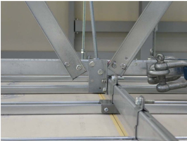
写真－8 試験体の状況（最大荷重時）
