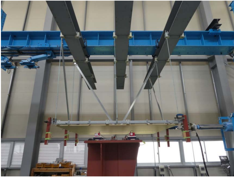
写真-3 試験体の状況（最大荷重時）
