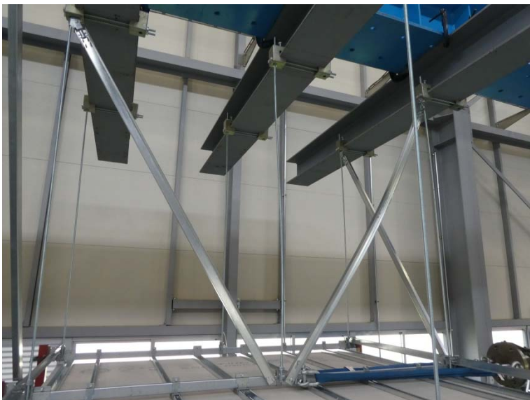
写真-4 試験体の状況（最大荷重時）
