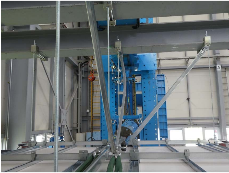
写真－9 試験体の状況（最大荷重時）
