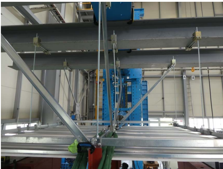
写真－10 試験体の状況（最大荷重時）
