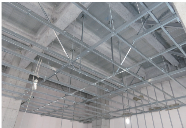
施工例：耐震スマート天井+在来天井仕様
